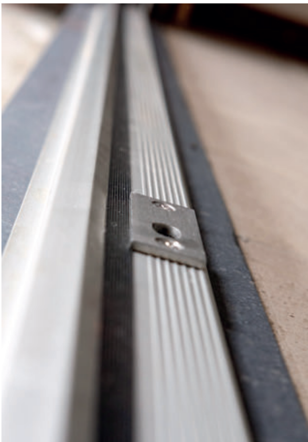
Detail thermisch onderbroken onderprofiel
